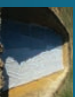
POSE DU GEOTEXTILE
