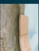
POSE DES MARGELLES
